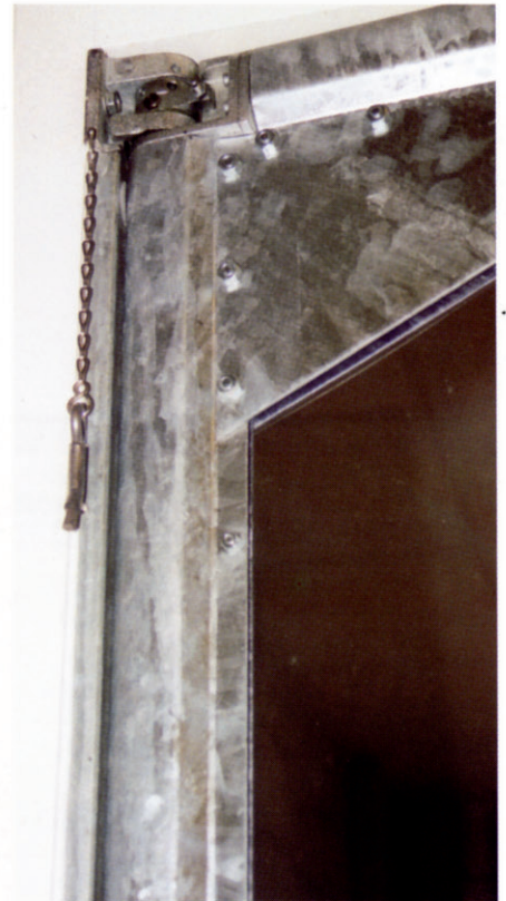
Durch einfaches Einstecken des Sicherungsstiftes kann der Flügel in 90° Stellung offengehalten werden.
