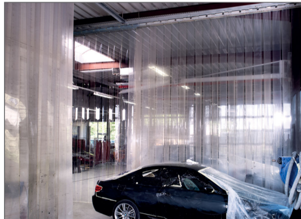
Arbeitsplatz 5 (von innen): Eingleisig verschiebbarer Streifenvorhang (links im Bild), QUICK-STRIP Scherenfaltsystem (rechts im Bild)
